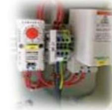
13 Chauffage d'appoint avec thermostat (intégré ou non)
