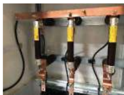
BC Strongo Avec coffret de protection et fusibles HT intégrés
