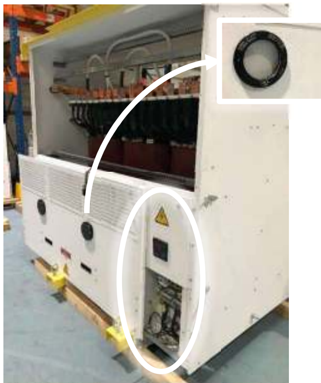
BC Strongo Avec coffret accessoires et hublots infrarouge intégrés
