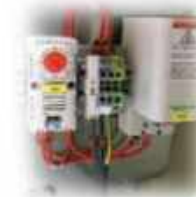
13 Raumheizgerät mit Thermostat (integriert oder nicht)
