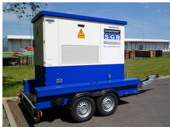
**LAHMEYER-Compactstationen®**, besonders die Baureihen **NDV400, NDV1000, NDV1200-2600** und **WPS2500**, eignen sich ideal für den Anschluss von Anlagen zur dezentralen Energieerzeugung aus regenerativen Energiequellen, beispielsweise Biogas- oder Photovoltaik-Anlagen
