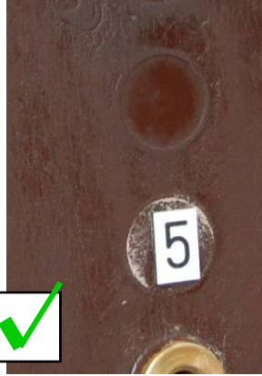
Şek. 14: İyi durumda. Yüzeylerde ve boyalarında küçük düzensizlikler
