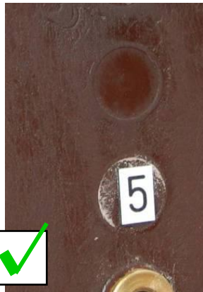
Рис. 14: В порядке. Незначительные дефекты поверхности и цвета
