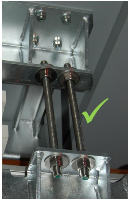
Värimerkinnät virheettömiä
